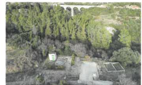
Station d'épuration actuelle à Arboras, avant le projet de travaux.
