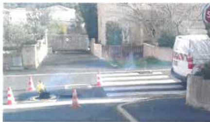
Test à la fumée dans le réseau assainissement
