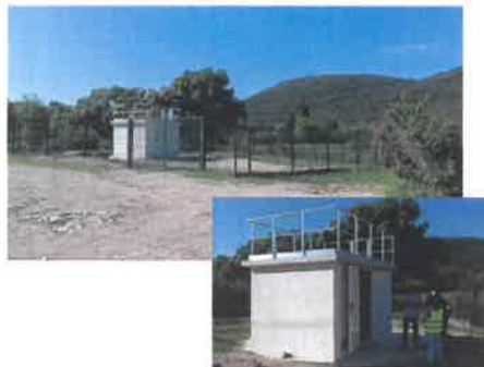
Forage des Moulères-patrimoine repris en Régie dès le 1er janvier 2022
