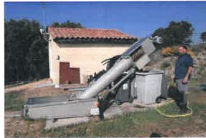
Tamis fin à la station de Montpeyroux
