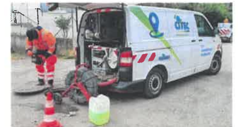
Intervention de la CITEC pour curage du réseau assainissement dans le cadre du marché de hydrocurage.
