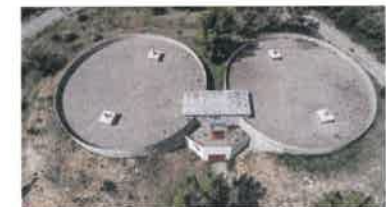
Réservoir de Montpeyroux
