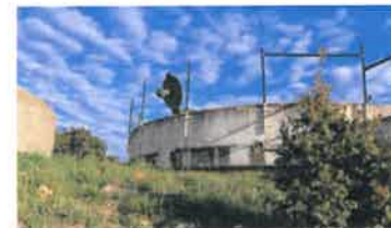
Réservoir de St Guiraud
